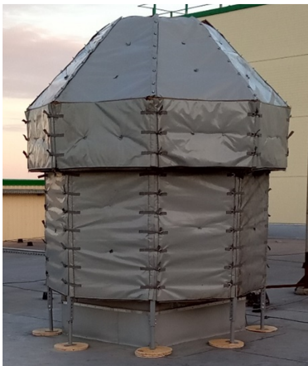
Рисунок 5 – Кожух для снижения шума вытяжной системы
